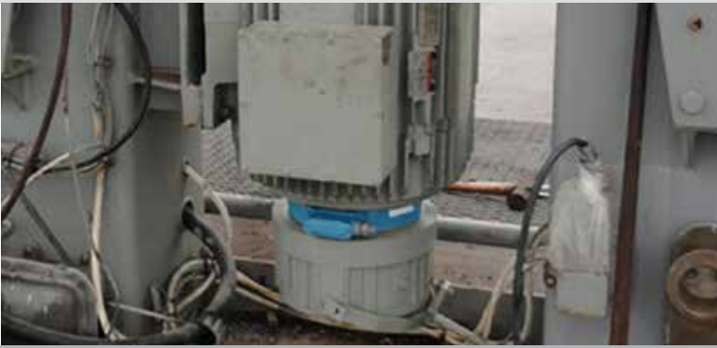
AV850 - Zwischen Bremse und Motor / Mounted Between Brake & Motor
